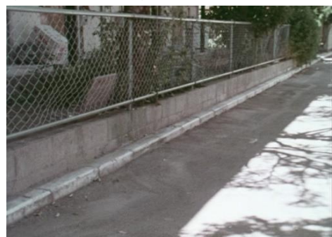
(下水道整備後)
