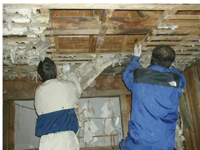
写真2. 上／天井絵の残存状況 下／天井絵の剥離作業
